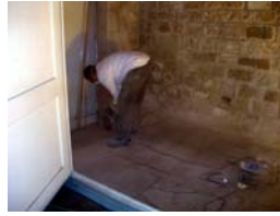
3)Afectació del paviment
