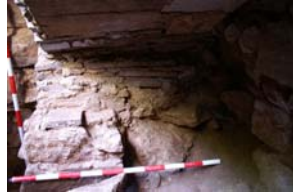
43)Detall pilastra u.e. 108
