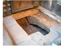
9)Voltes u.e. 103 i u.e. 105 i banqueta u.e. 104
