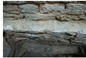
53)Banqueta u.e. 212 i estructura u.e. 219
