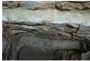
52)Banqueta u.e. 212 i estructura u.e. 219
