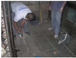
2)Extracció lloses paviment
