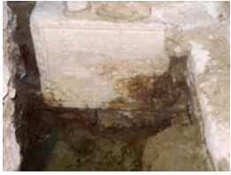
35)Vista pedestal u.e. 214 durant la excavació
