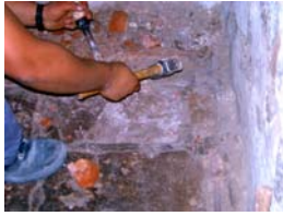
2)Extracció manual del paviment
